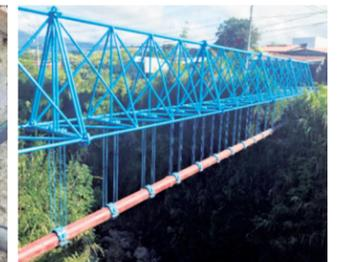
Construcción puentes canales para soportar tubería hierro dúctil en cruces de río.
